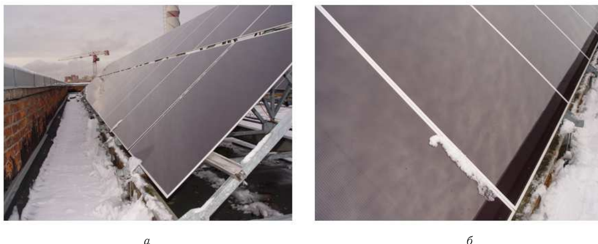
Рис. 3. Образование льда и инея на панелях при нулевой температуре: а — Иней на нижней части панели; б — образование льда на стыке при 0°C
