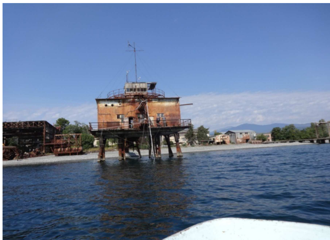
Рис. 1: Эстакада ГИАНА, с которой проводились многослойные измерения течений и вертикального распределения температуры и скорости звука
